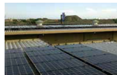
静鉄大井川倉庫 焼津市西島
